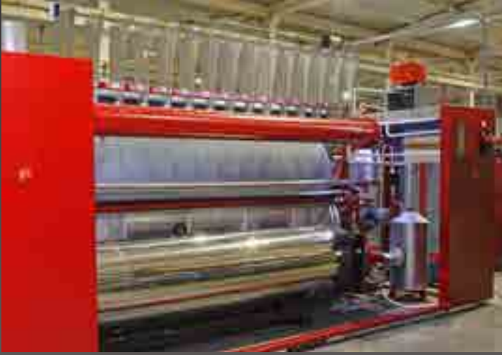
gaz ısıtma sistemi
